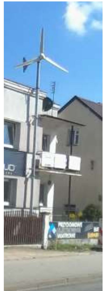
Fot. 7 Instalacja Turbiny wiatrowej – Starogard Gdański ul. Gdańska
