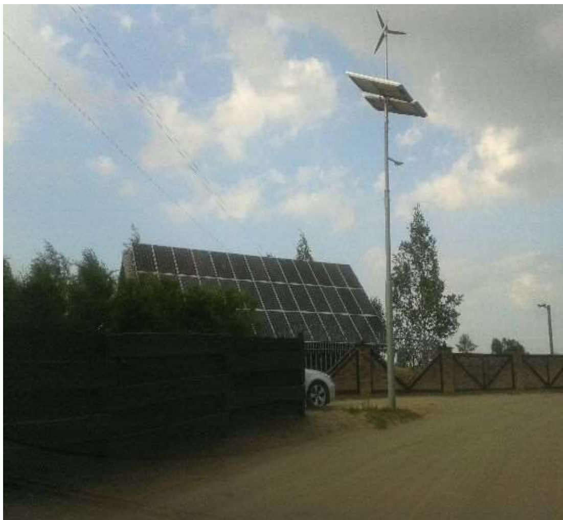
Fot 4. Instalacja składająca się z systemu 39 paneli fotowoltaicznych Szteklin - gmina Lubichowo woj. pomorskie
