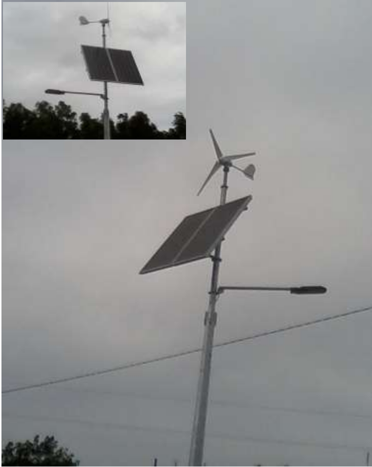
Fot. 5 Instalacja składająca się z turbiny wiatrowej oraz paneli fotowoltaicznych zasilająca Lampę uliczną (gmina Strzegowo woj. mazowieckie)
